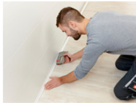
Zierleisten können schnell und einfach getackert werden.
